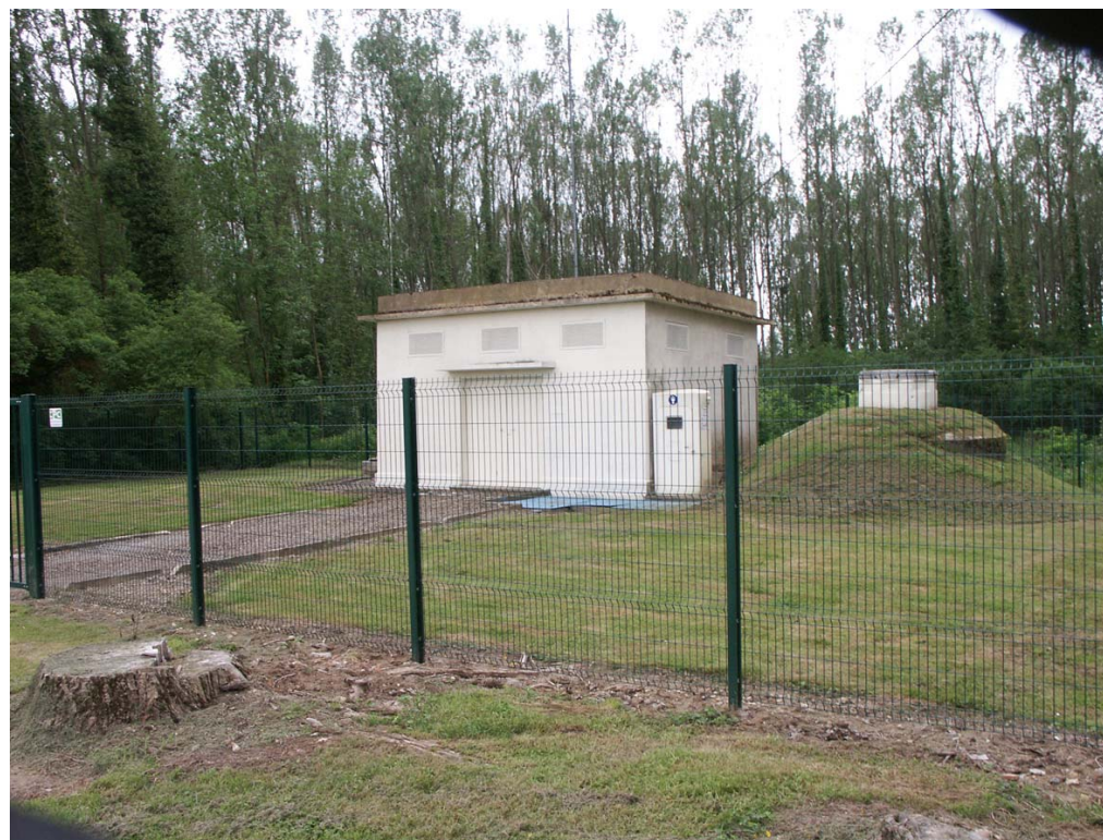
Captage de Chevincourt
