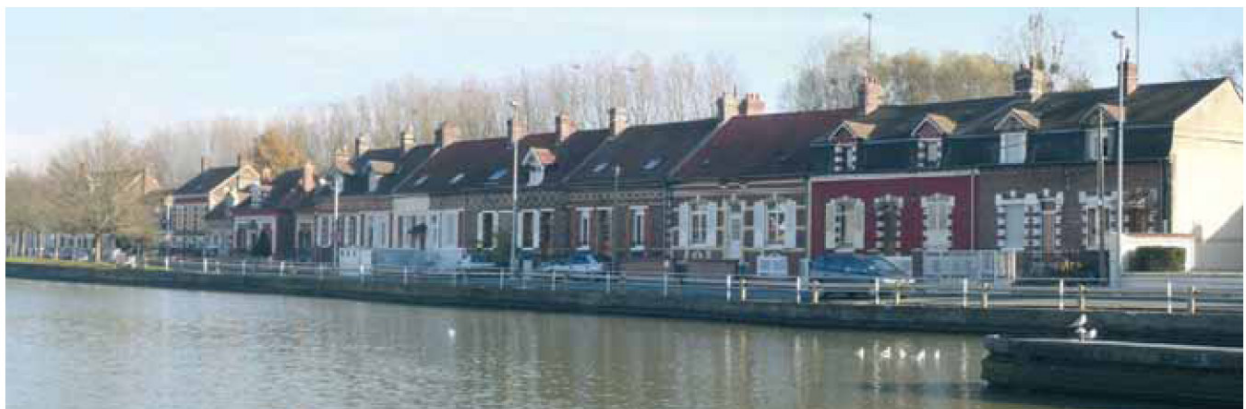
Cité de bateliers et port, Longueil-Annel fut jusque dans les années 1960 un port marinier d'importance nationale.
